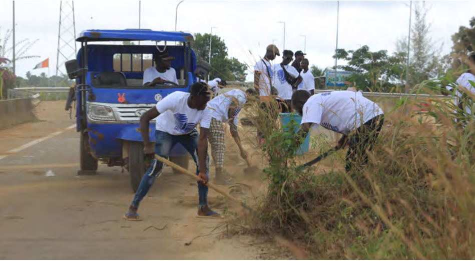
Déserbage des emprises prévues pour le péage
