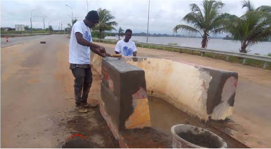
Reconstruction des balises du péage par les maçons de l'ONG
