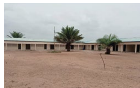
Collège de proximité à Adessé
