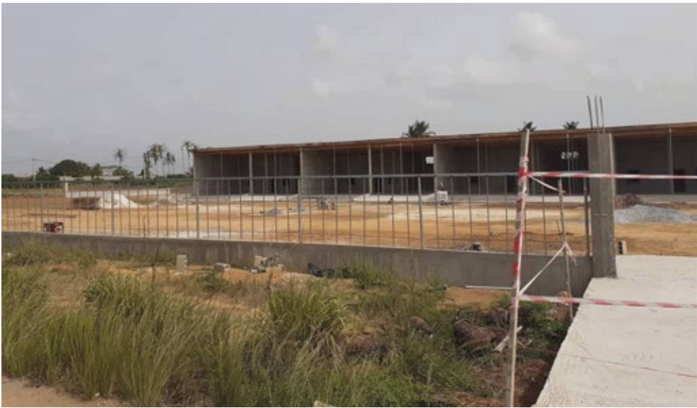
Chantier de la nouvelle gare routière moderne de Jacqueville
